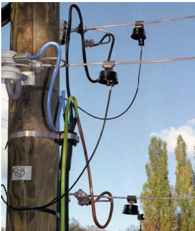
Ugradnja odvodnika na nadzemnom neizoliranom vodu.
